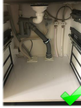
Vuotokaukalo, läpiviennit tiivistetty tiivistyskappaleella C
