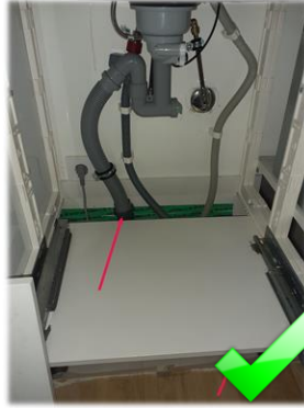
Vuotokaukalo, läpiviennit tiivistetty tiivistysteipillä C
