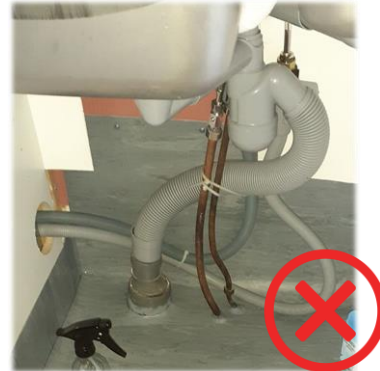
Vuodonilmaisuus hyvä, toteutettu muovimatolla. Kannakointi puutteellinen!
