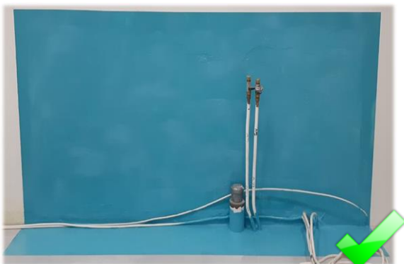
Siveltävä vedeneriste ammattilaisen toimesta
