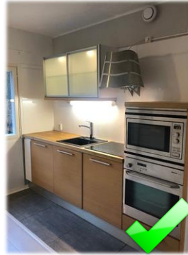
Liesituuletin aktiivihilisuodattimella. poistoilmaventtiili seinässä
