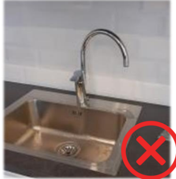
Hanan rajoitin puuttuu, hana kääntyy pesualtaan yli
